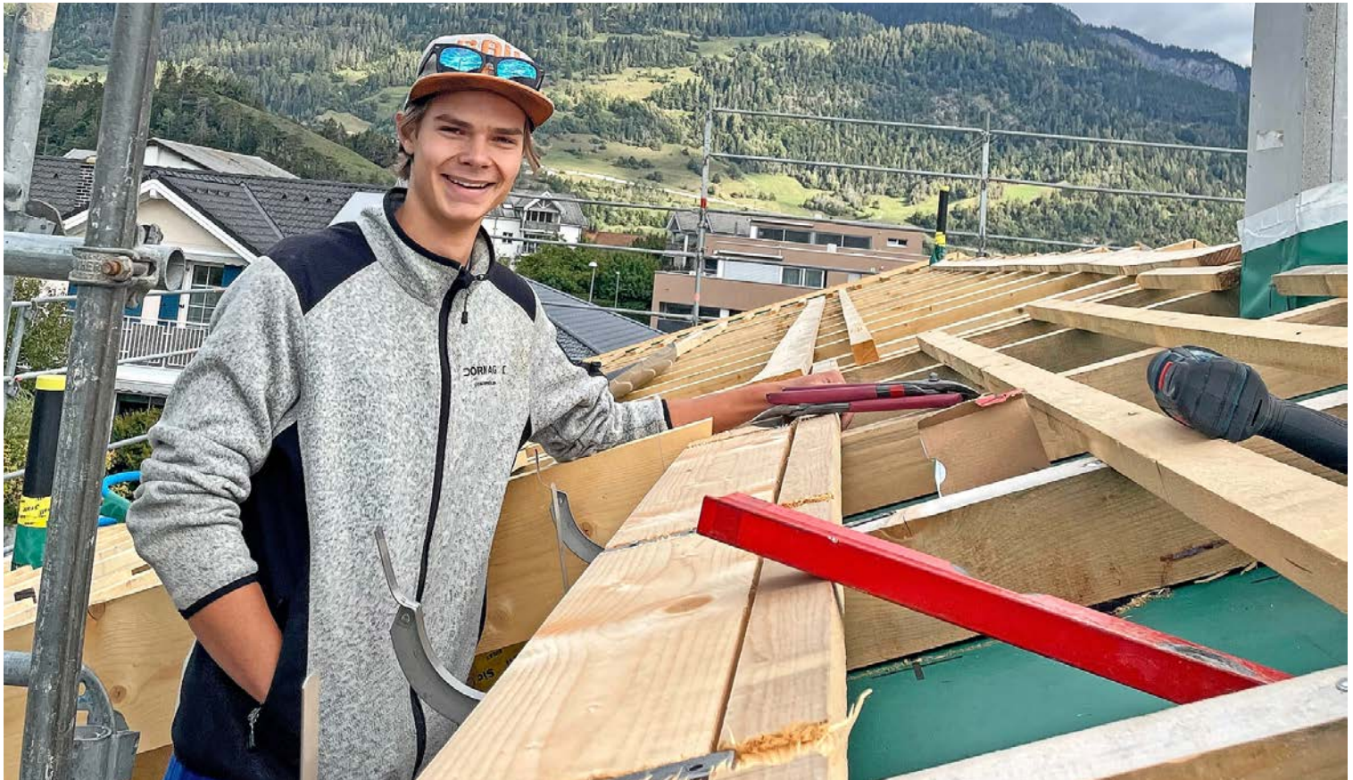
Lars Cavegn an seinem Arbeitsplatz in luftiger Höhe – als Spengler sollte man schwindelfrei sein.
